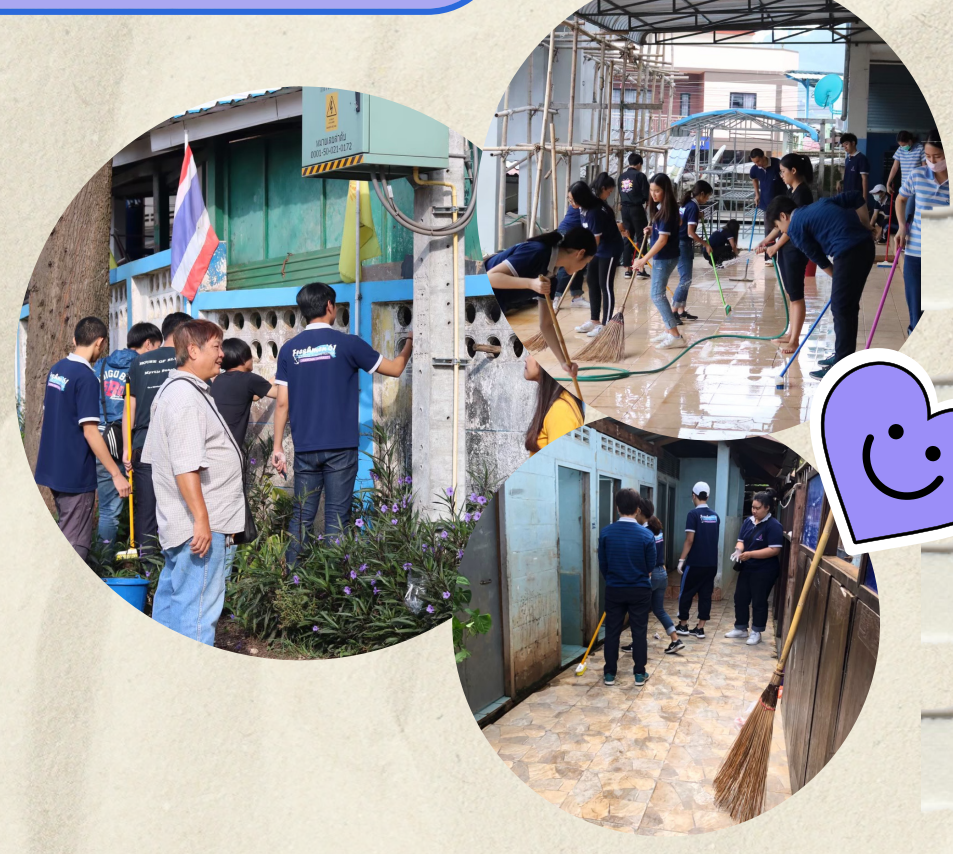
ปรับภูมิทัศน์ภายในโรงเรียนโดยทำความสะอาดภายในห้องเรียน ห้องน้ำ กำแพงโรงเรียนและทาสี
